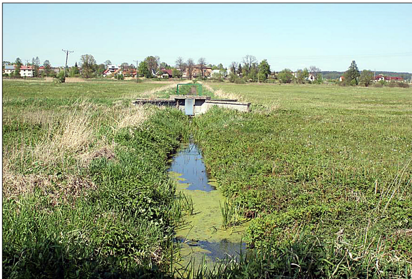
Fot. 1. Rów melioracyjny częściowo konserwowany z zastawką piętrzącą wodę, fot. A. Kiryluk Phot. 1. Meliorated ditch part conservation with weir water damming, phot. A. Kiryluk
